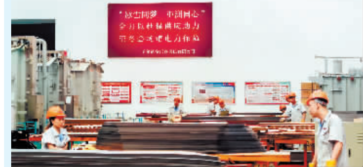
哈尔滨工投集团权属企业哈尔滨变压器公司设计制造哈尔滨国际会展中心电力设施更新改造所需的两台主变。
