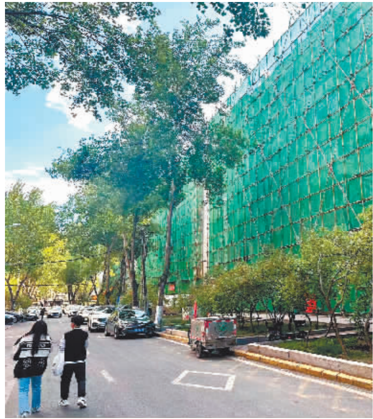
老旧小区改造施工现场。
