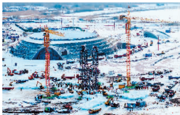
冰雪大世界施工现场。“哈报手机记者”傅强摄
