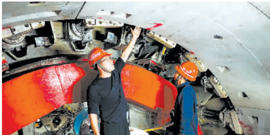
河松街施工盾构机内部安全检查。
