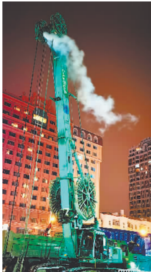
成槽机冬季带高温蒸汽设备施工。
