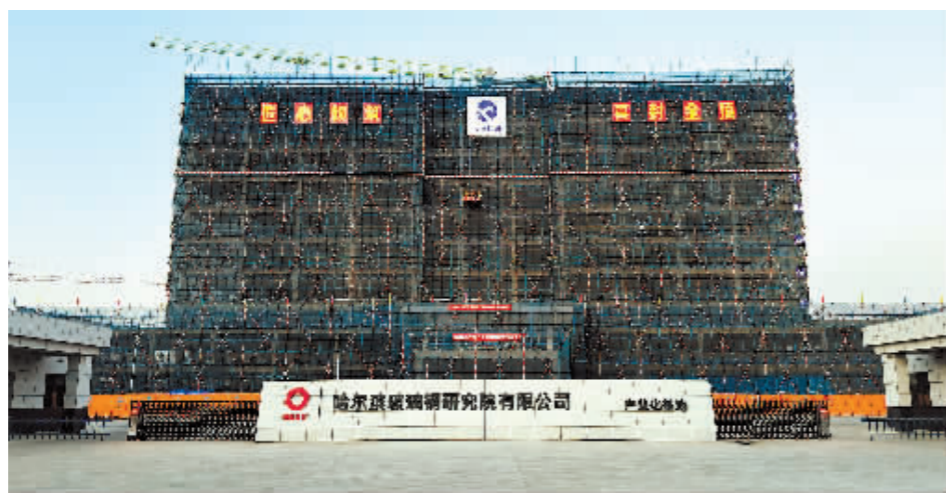
国家新材料科技产业化基地二期项目正在建设中。
