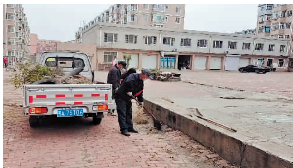
排查乱堆放,清理小区杂物。
