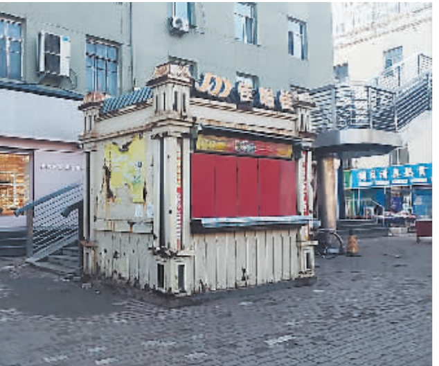
香坊区锅炉厂公交站早餐亭锈蚀。
