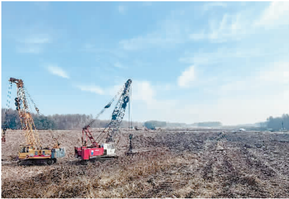
哈尔滨(木兰)通用航空机场项目破土动工。
