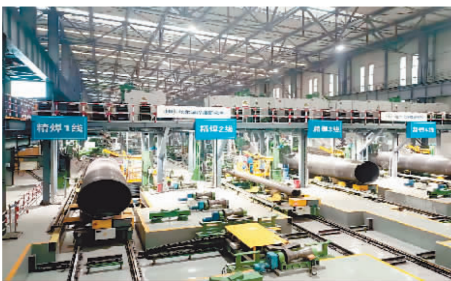
哈焊所实现“焊材—工艺—装备—质控”全面自主可控,有力支撑国家重大管线工程建设。
