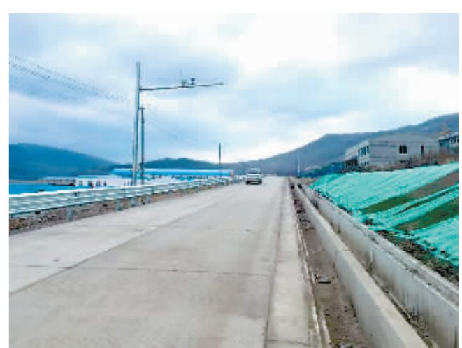
电站连接公路全线贯通。
