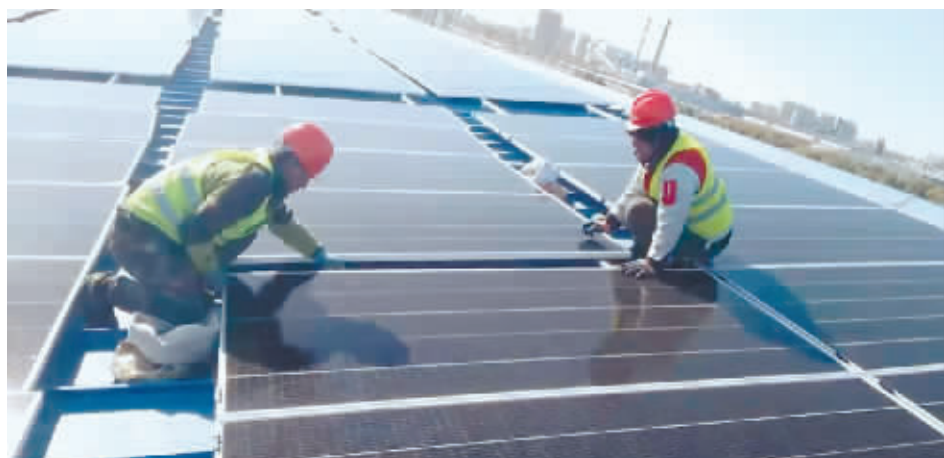
工人拼装光伏电板。
