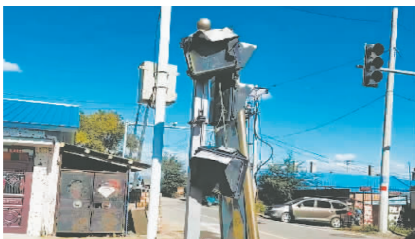
木兰县振兴大街与东环路交口信号灯损坏。
