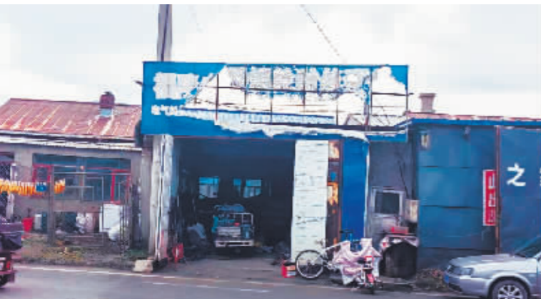
五常市葵花大街74号牌匾破损。
