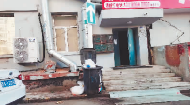
道外区尚朴街114号门前垃圾桶破损垃圾外溢。
