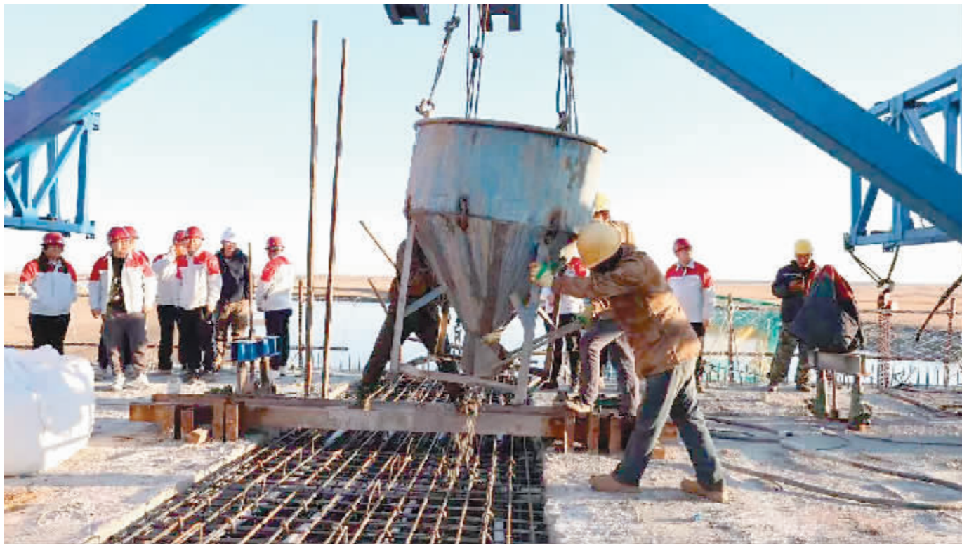
呼兰河特大桥施工现场。
