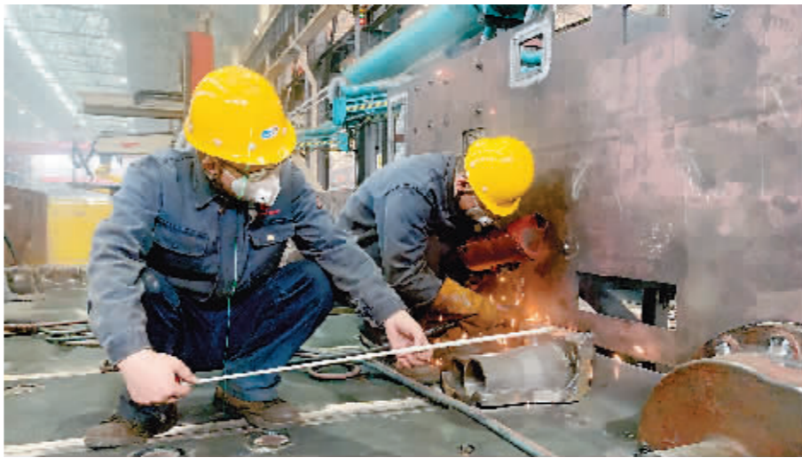
工人进行焊接作业。
