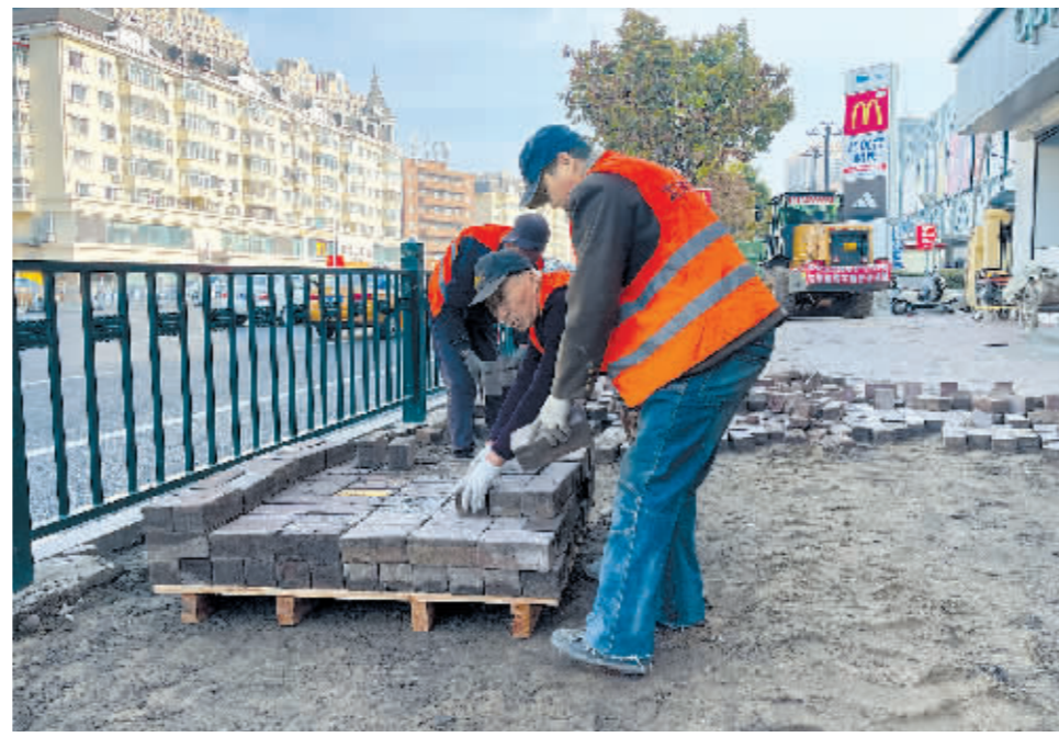
城乡路道路更新改造现场。
