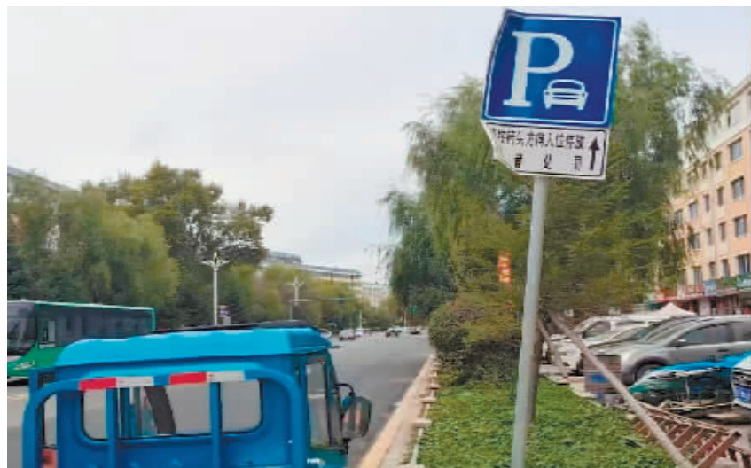
通河县人和大街标识牌倾斜破损。
