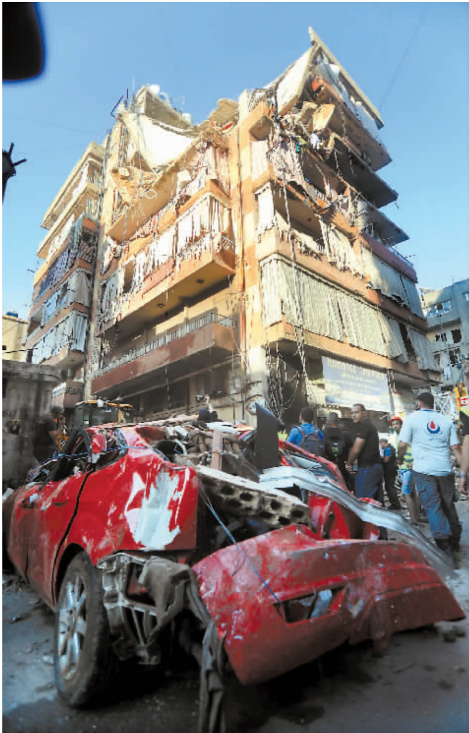
这是9月24日在黎巴嫩贝鲁特拍摄的一栋在以色列空袭中受损的建筑。新华社发
