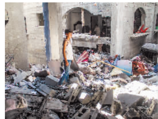
巴勒斯坦人在加沙地带北部杰巴利耶地区查看房屋损毁情况。
