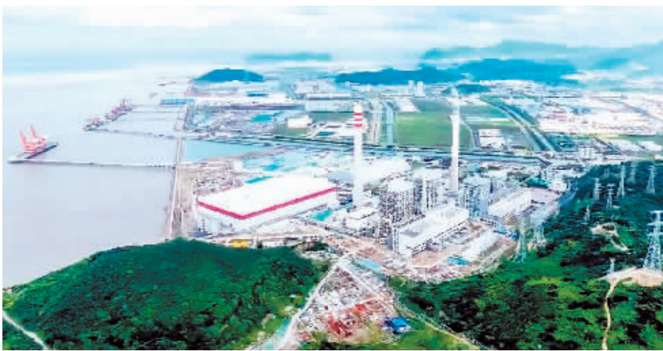
国能舟山三期扩建工程项目现场。
