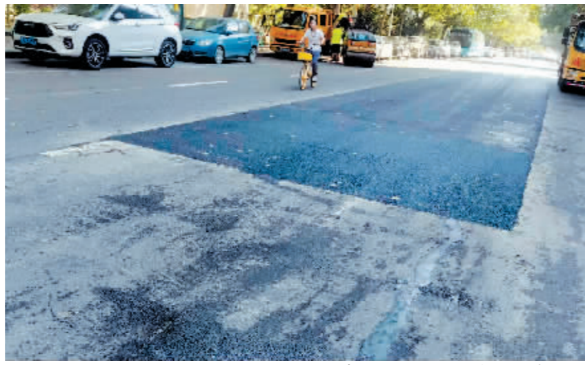
南岗区衡山路58号门前路面修复平整。
