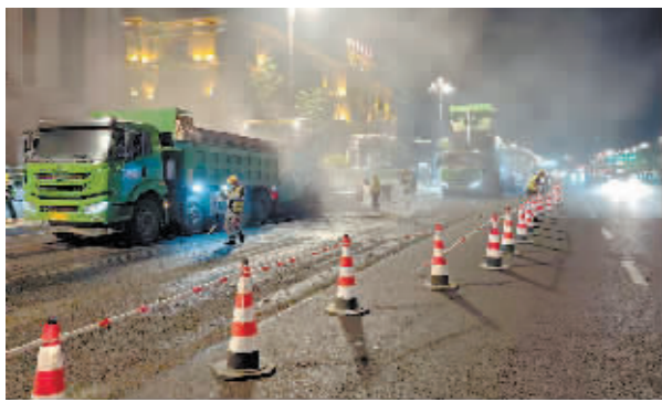
机械组合铺路。
