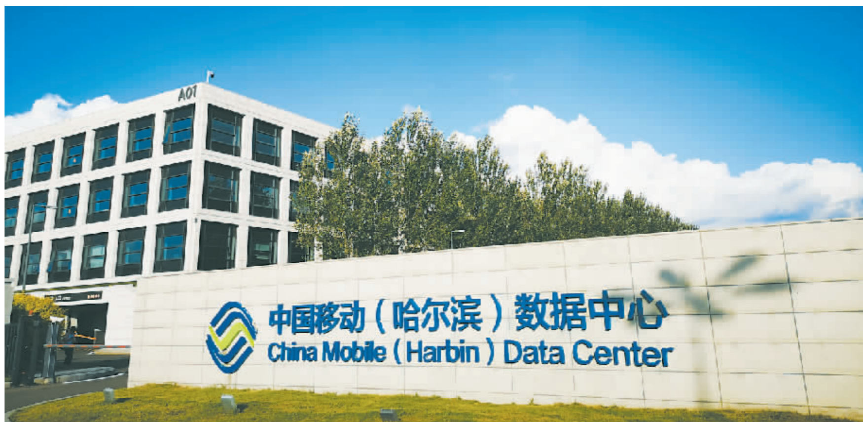
中国移动哈尔滨数据中心园区。
