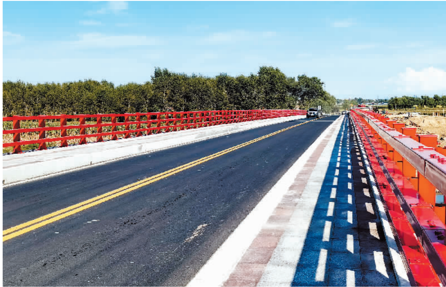
八一和平大桥竣工通车。
