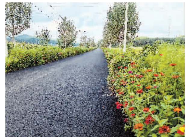
开满鲜花的新建农村公路。
