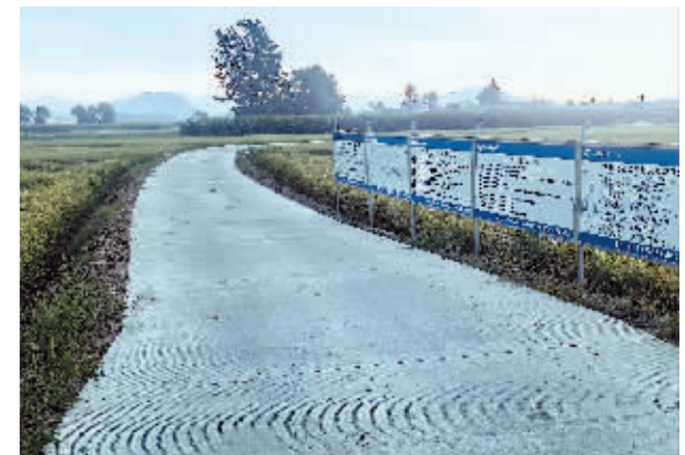
新建的田间道路。
