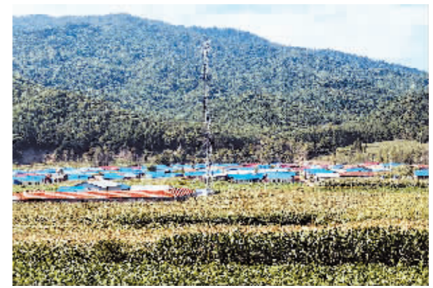
沙河子镇大柜村大柜屯新建的蓝色彩钢房。
