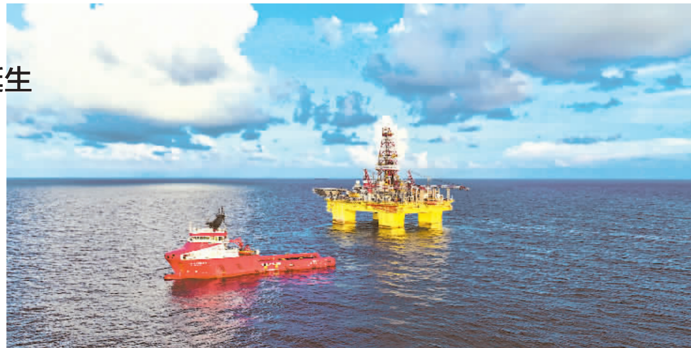
我国自主设计建造的深水钻井平台,作业能力达到世界先进水平。 中国海油供图
