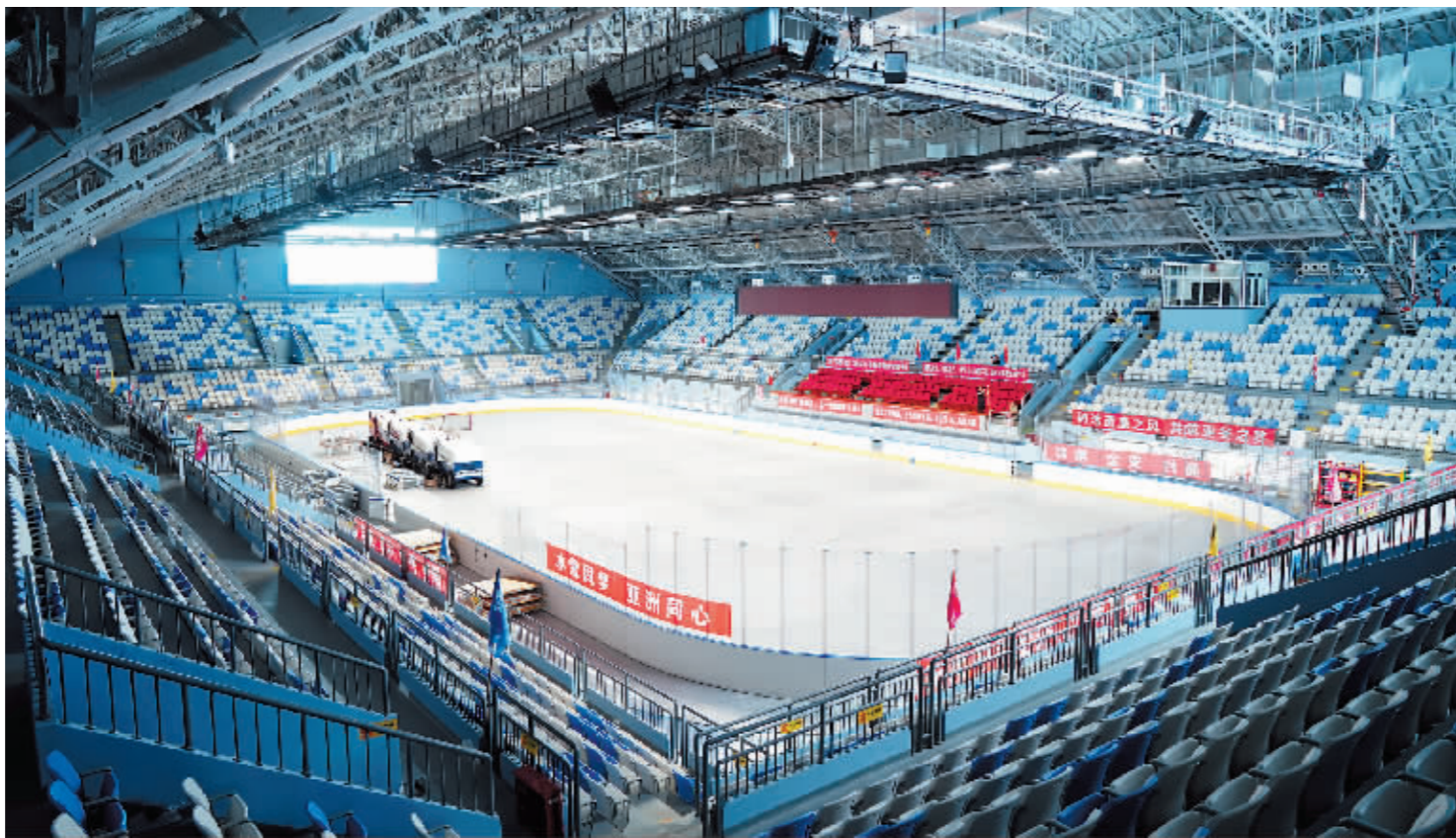
哈尔滨冰球馆提升改造工程完工。本报记者 韩伟摄
