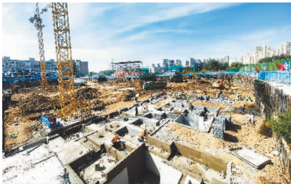
南岗区同济街地块项目施工现场。
