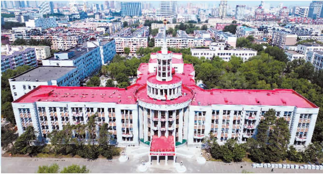
黑龙江中医药大学主楼修缮工程竣工。
