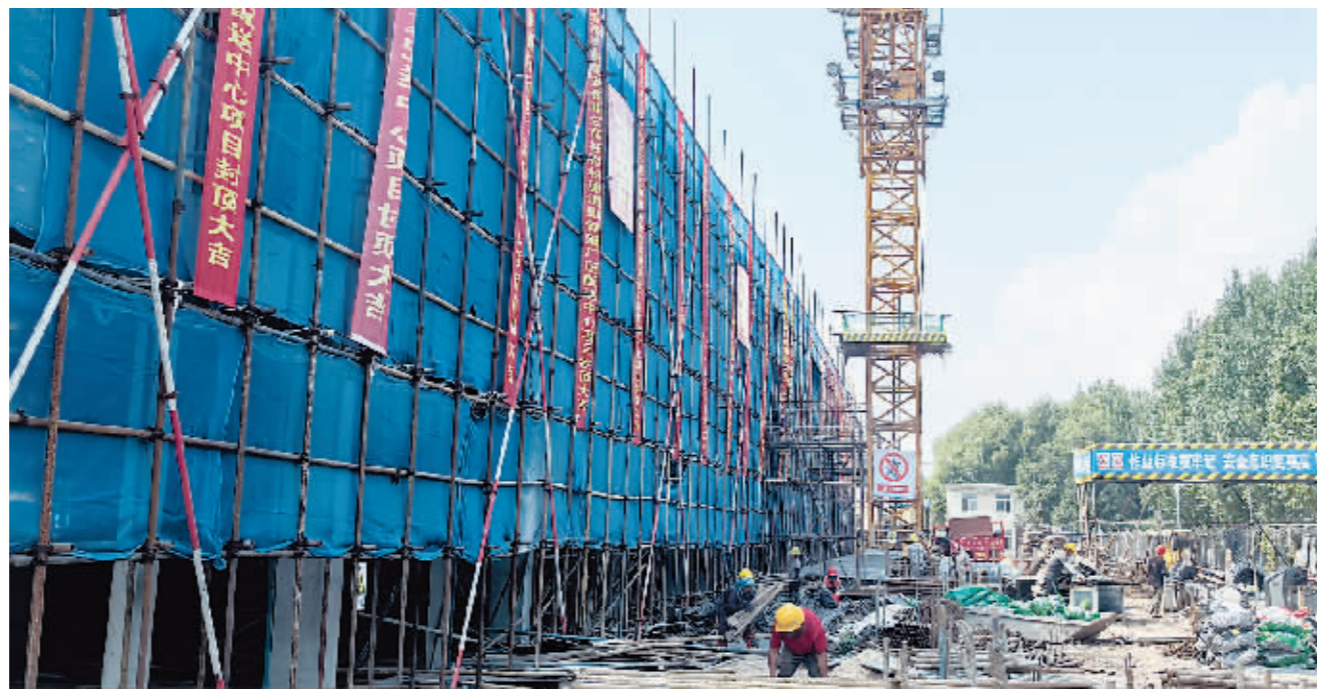
秋林·里道斯建设项目建设施工现场。
