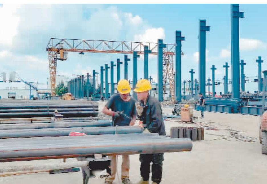
工人在焊接吊架。
