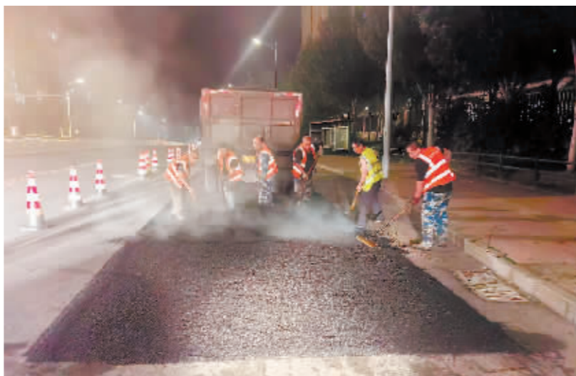
公滨路维修破损路面。
