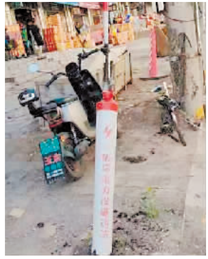
宾县大干路 3 号门前线缆整改前后。
