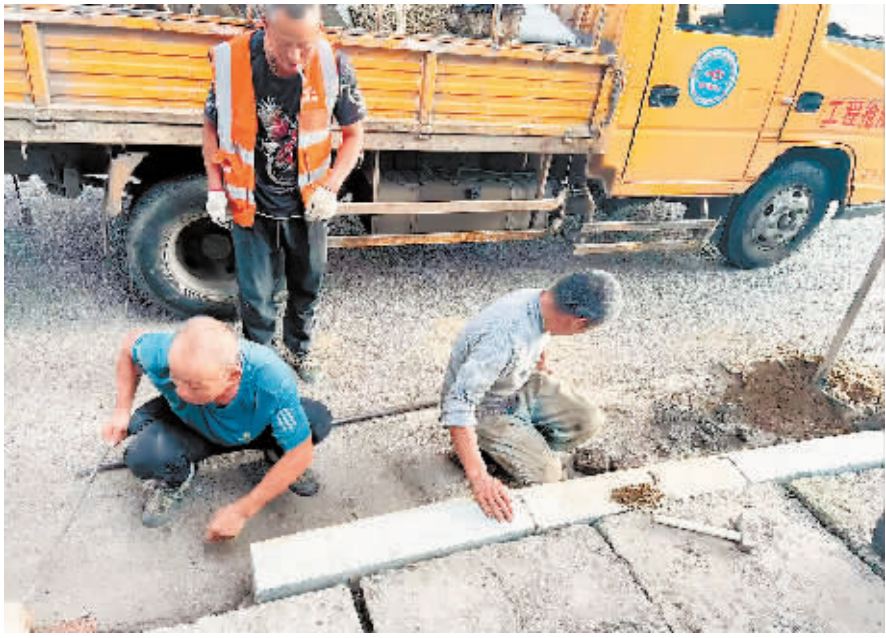
长江路四环桥附近维修边石。
