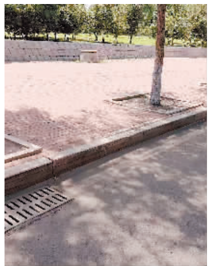
道外区临堤街 1 号对面垃圾堆整改前后。
