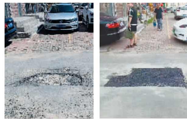
道外区丰润街177号道路破损整改前后。
