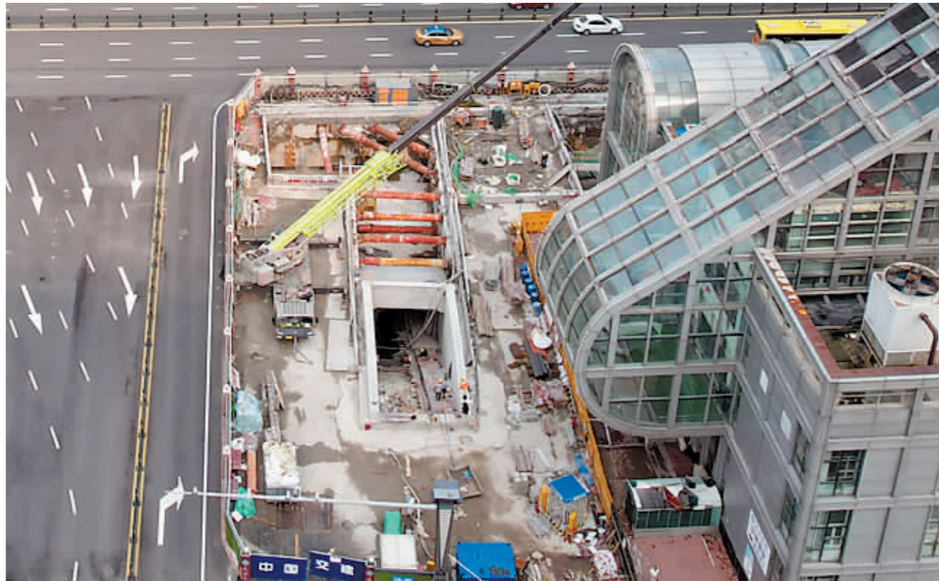
地铁3号线上海街站建设现场。
