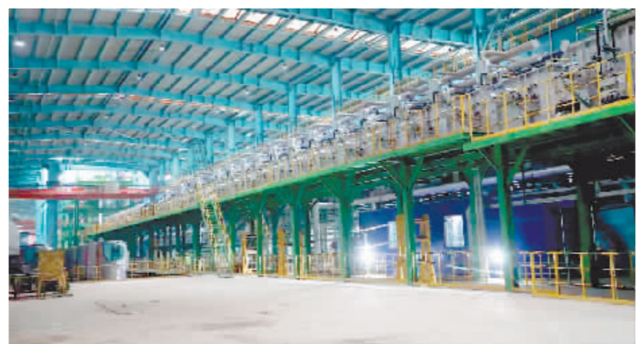
“建龙阿钢”新材料镀锌3号机组进入试生产阶段。
