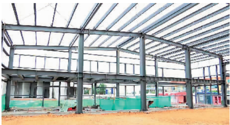
尚志市公路客运北站“1号”站房主体完工。
