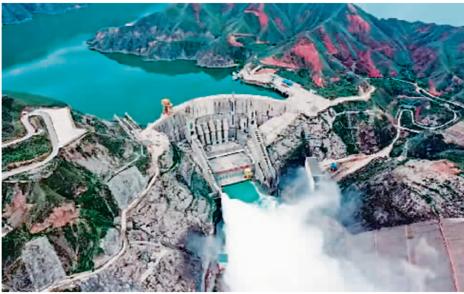
哈电集团改造的1号机组在李家峡水电站投用。
