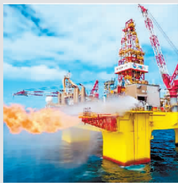
陵水36-1气田进行测试作业。
