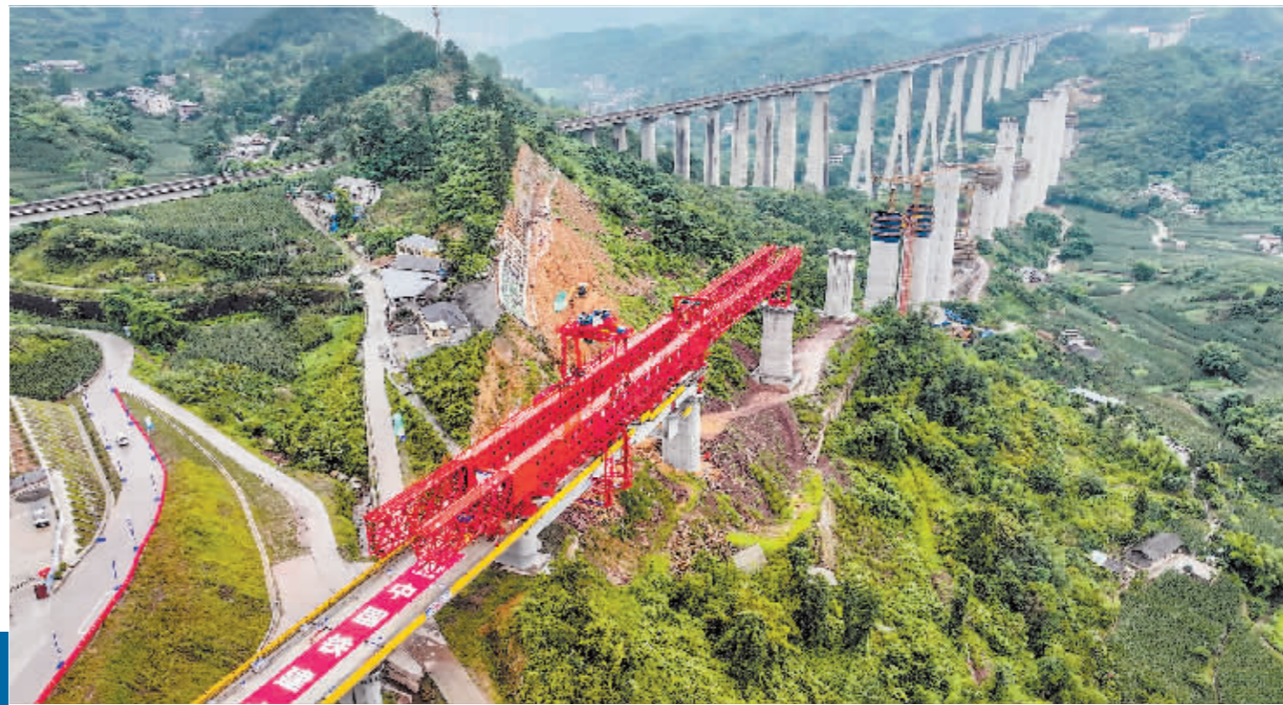
6月26日，渝万高铁新桥双线特大桥建设现场。新华社发
