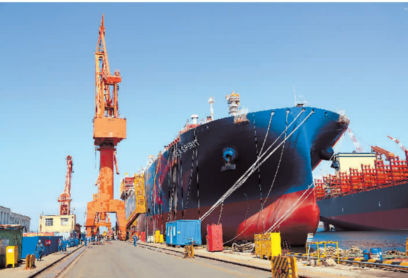
6月15日,在中国船舶集团大连船舶重工集团有限公司拍摄的正在建造的大型液化天然气(LNG)运输船。新华社发
