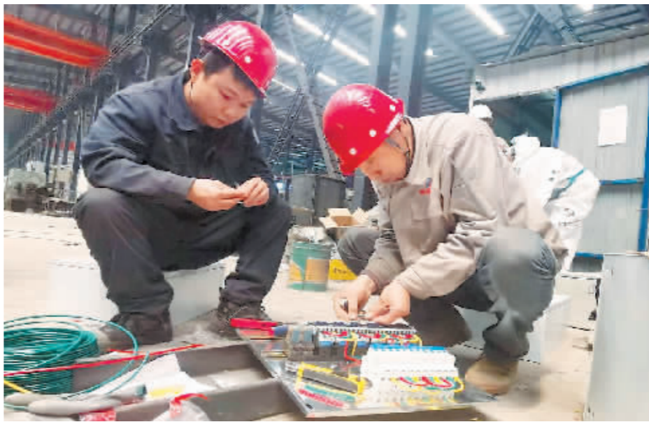
工作人员调试机器设备。
