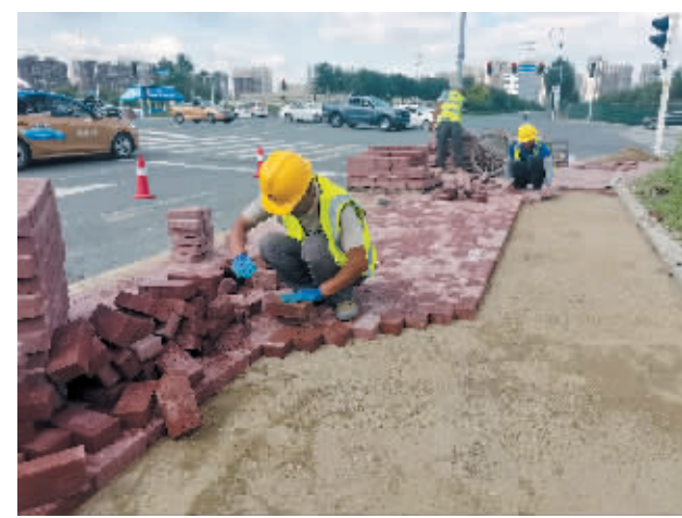
改造施工现场。
