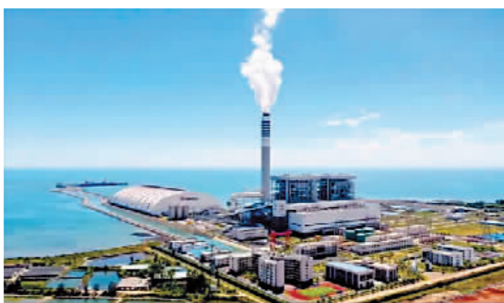
哈电成功中标广东大唐国际雷州发电公司百万二次再热机组掺烧生物质多燃料耦合发电EPC项目。
