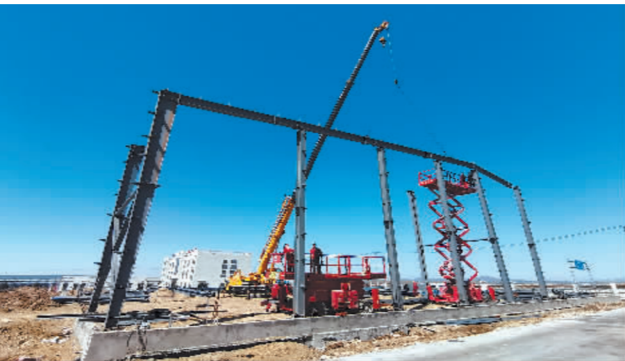
施工人员在紧张有序地作业。
