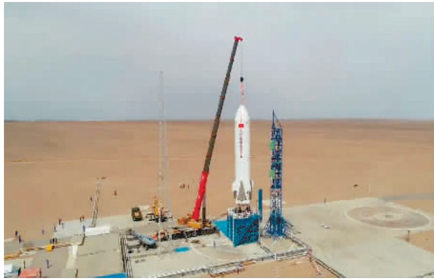
吊装现场。(中国航天科技集团八院供图)
