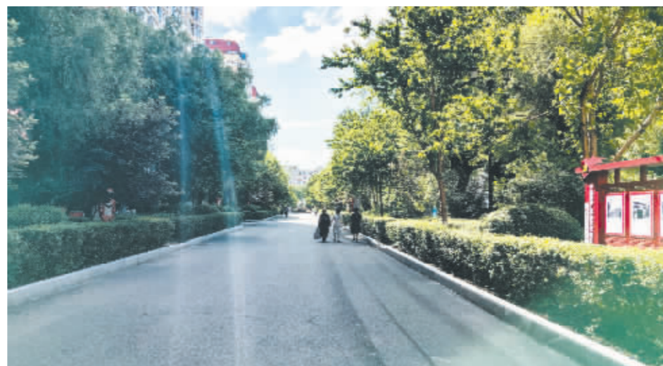
小区内新铺装的路面。
