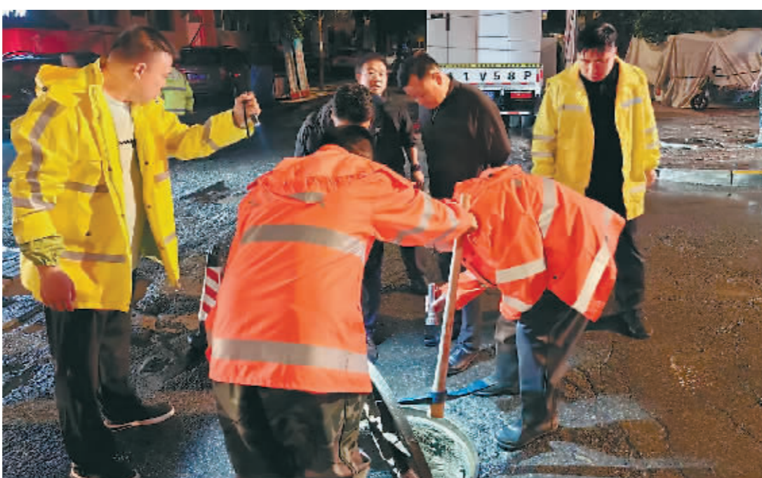
抢险队员清理堵塞的井口。
