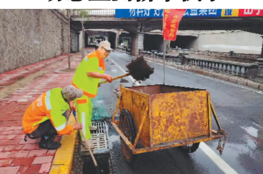
环卫工人清沟排水口淤泥。
