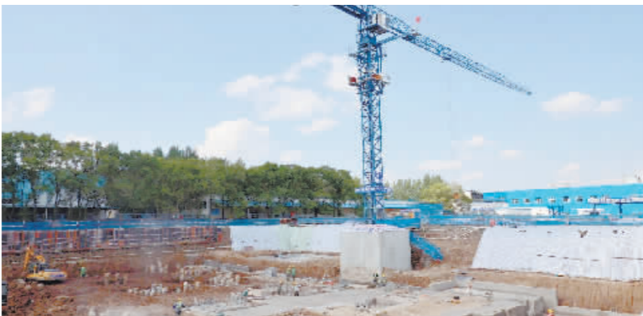
施工现场一派繁忙景象。
