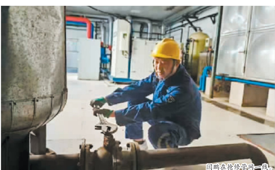
闫鹏在抢修管网一线。
