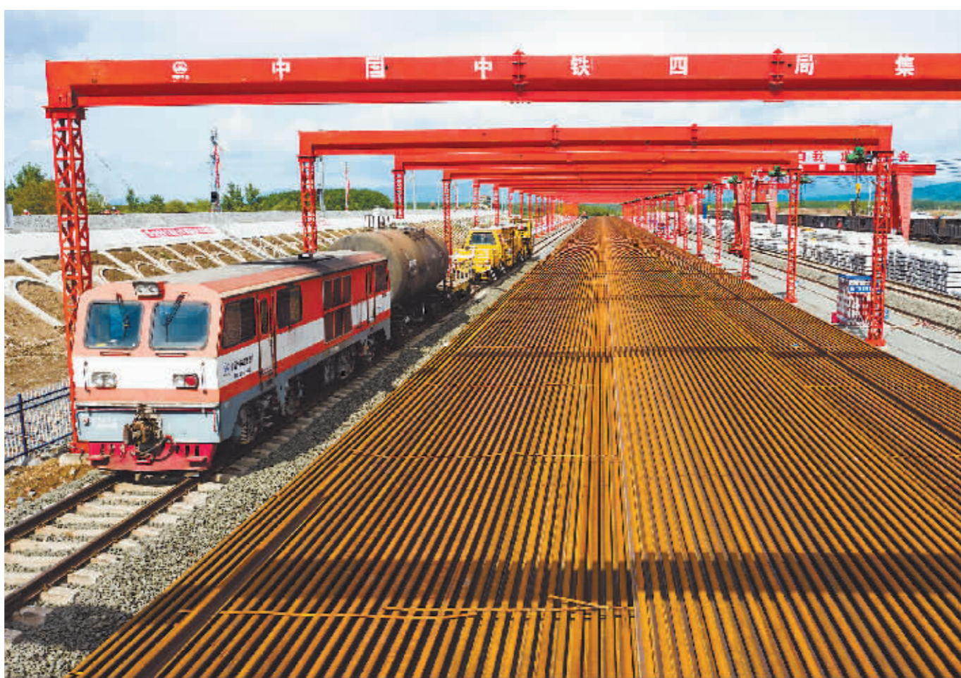
哈伊高铁铺轨施工现场。哈铁供图
