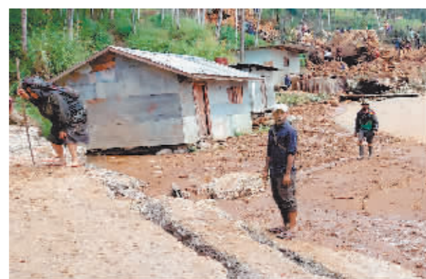
山体滑坡现场。
