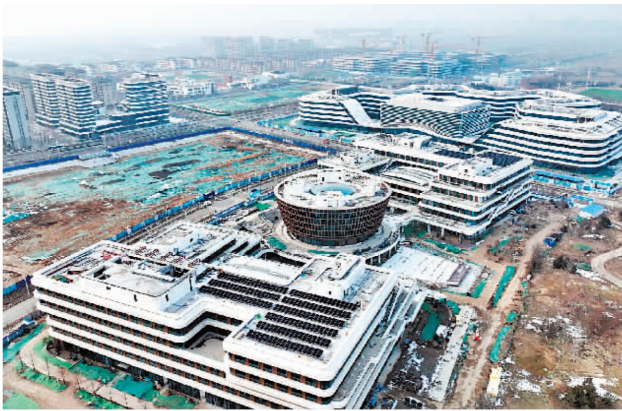
建设中的雄安中国电信智慧城市产业园。新华社发
