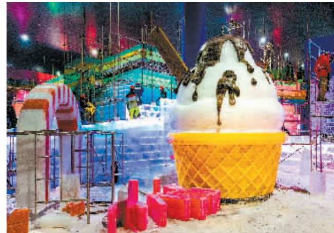
建设中的梦幻冰雪馆内景。
